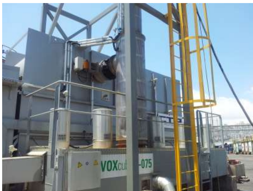
בתמונה: מתקן RTO חדש שהותקן בפז שמנים בנוב' 2012
