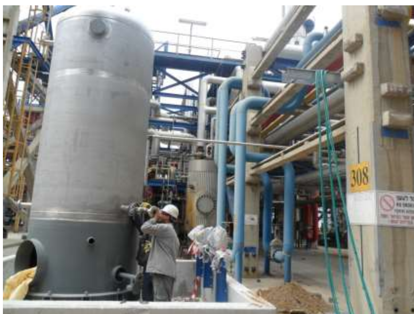
בתמונה: מערכת SNCR חדשה בהתקנה במתקן האיזומריזציה
