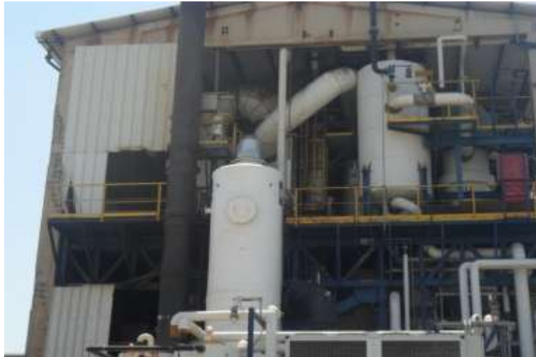
בתמונה: סקרבר טיפול בריחות ובגזים חומציים שהותקן ב-2011 באלקון.
