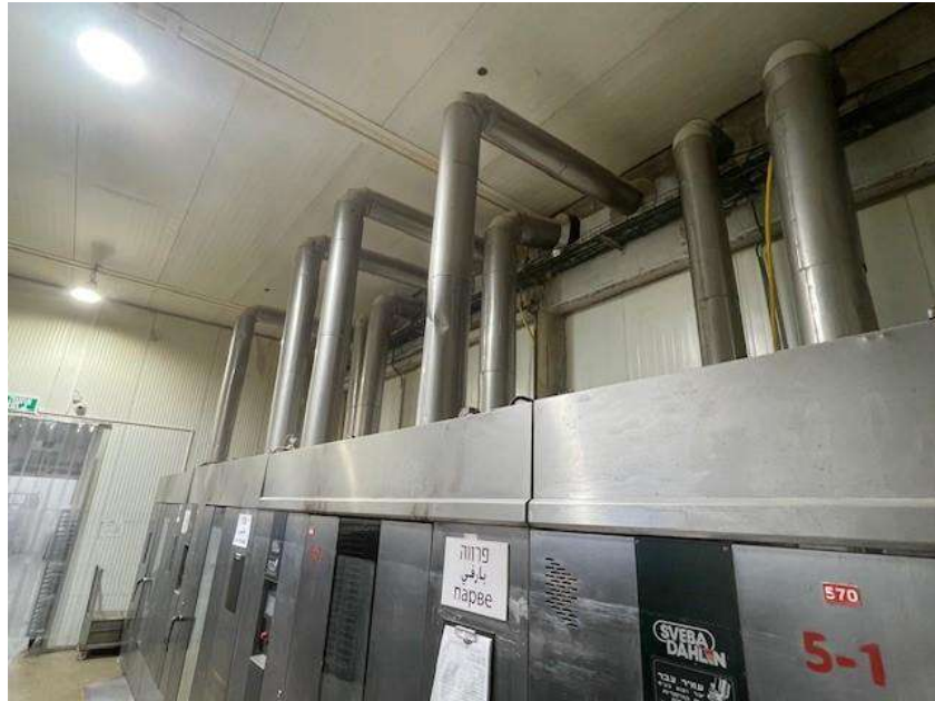
תמונה 14: מערכת יניקה במפעל ליצור מזון במפרץ חיפה
