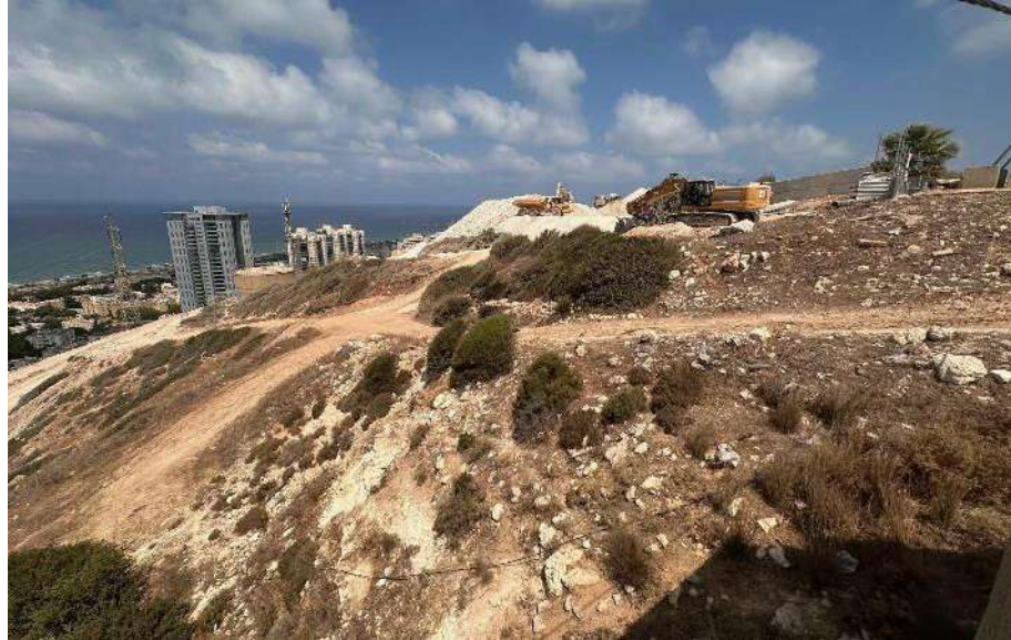
תמונה 17: סלילת כביש כבביר בחיפה
