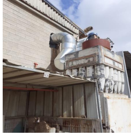
תמונה 17 - מערכת סינון במפעלי מ.מוטי
