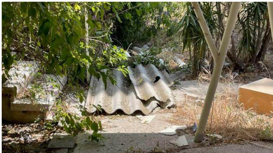
תמונה 16 : פירוק אסבסט בשיפוץ דירה בנווה שאנן, חיפה
